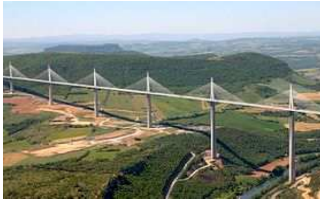
Viaduc Millau - Michel Virlogeux
